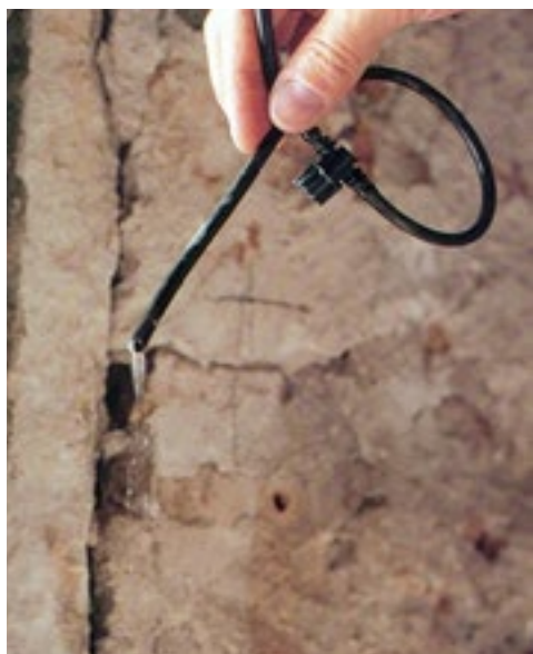
Fig. 9 - Desalinizzazione dei muri – particolare dei tubi utilizzati.
