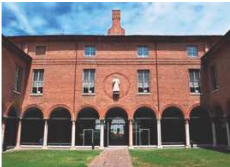
Fig.2 Ferrara, Palazzo Renata di Francia: il fronte esposto a Sud della corte interna
