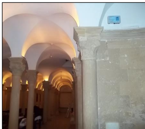
Fig.17 – Uno dei due dispositivi Domodry installato all'interno della Cripta
