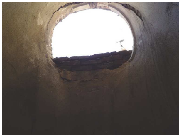
Fig.7 – Fase di liberazione della tamponatura di uno dei quattro abbaini sopra l’aula
