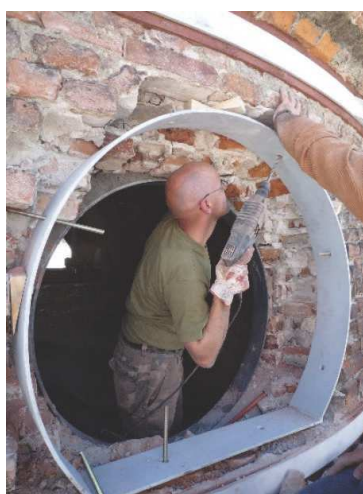
Figg.8, 9, 10 – Finestra del tamburo liberata della tamponatura, fissaggio del telaio strutturale di cerchiaggio della finestra sul tamburo, serramento e telaio strutturale delle finestre sul tamburo.
