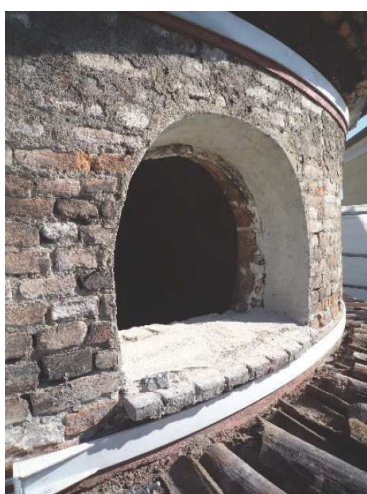
Figg.8, 9, 10 – Finestra del tamburo liberata della tamponatura, fissaggio del telaio strutturale di cerchiaggio della finestra sul tamburo, serramento e telaio strutturale delle finestre sul tamburo.
