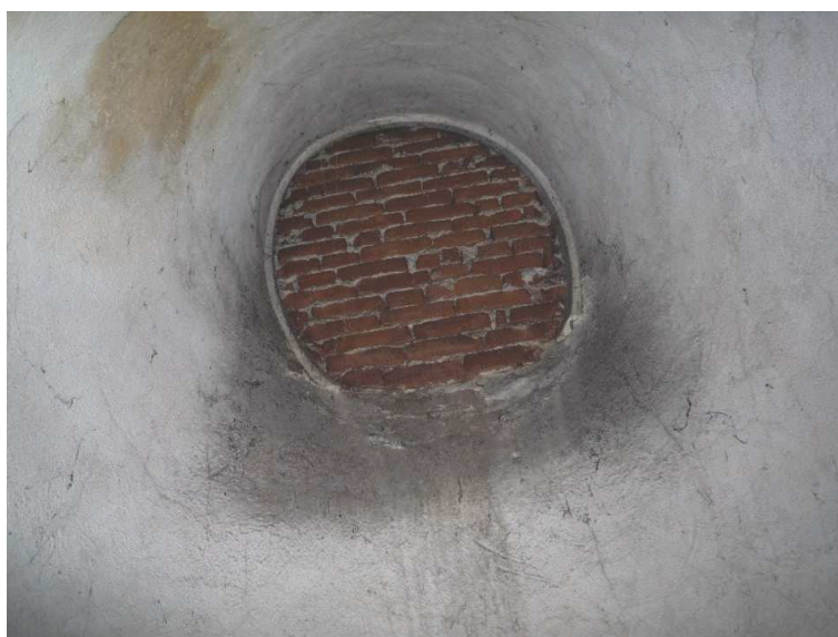
Fig.6 – Tamponatura di uno dei quattro abbaini sopra l'aula
