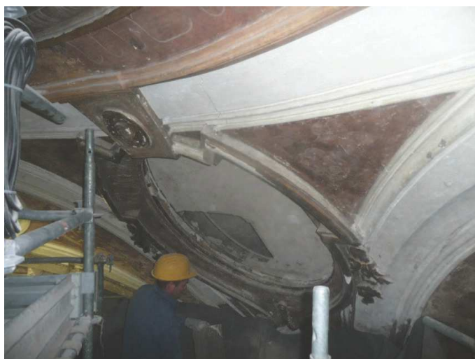
Fig.15 – fase di “strappo” delle superfici decorate precedente all’apertura delle finestre di collegamento luministico con l’abbaino sovrastante la volta dell’aula chiesa.
