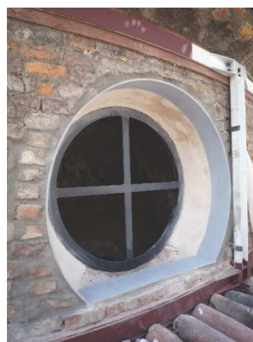
Figg.8, 9, 10 – Finestra del tamburo liberata della tamponatura, fissaggio del telaio strutturale di cerchiaggio della finestra sul tamburo, serramento e telaio strutturale delle finestre sul tamburo.
