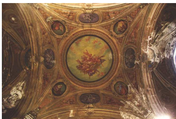
Figg.4, 5 – Volta sovrastante l'aula prima e dopo l'intervento di restauro
