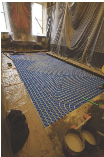
Figg.13, 14 – Posa degli elementi di riscaldamento radiante nella sacrestia durante e al termine del restauro.
