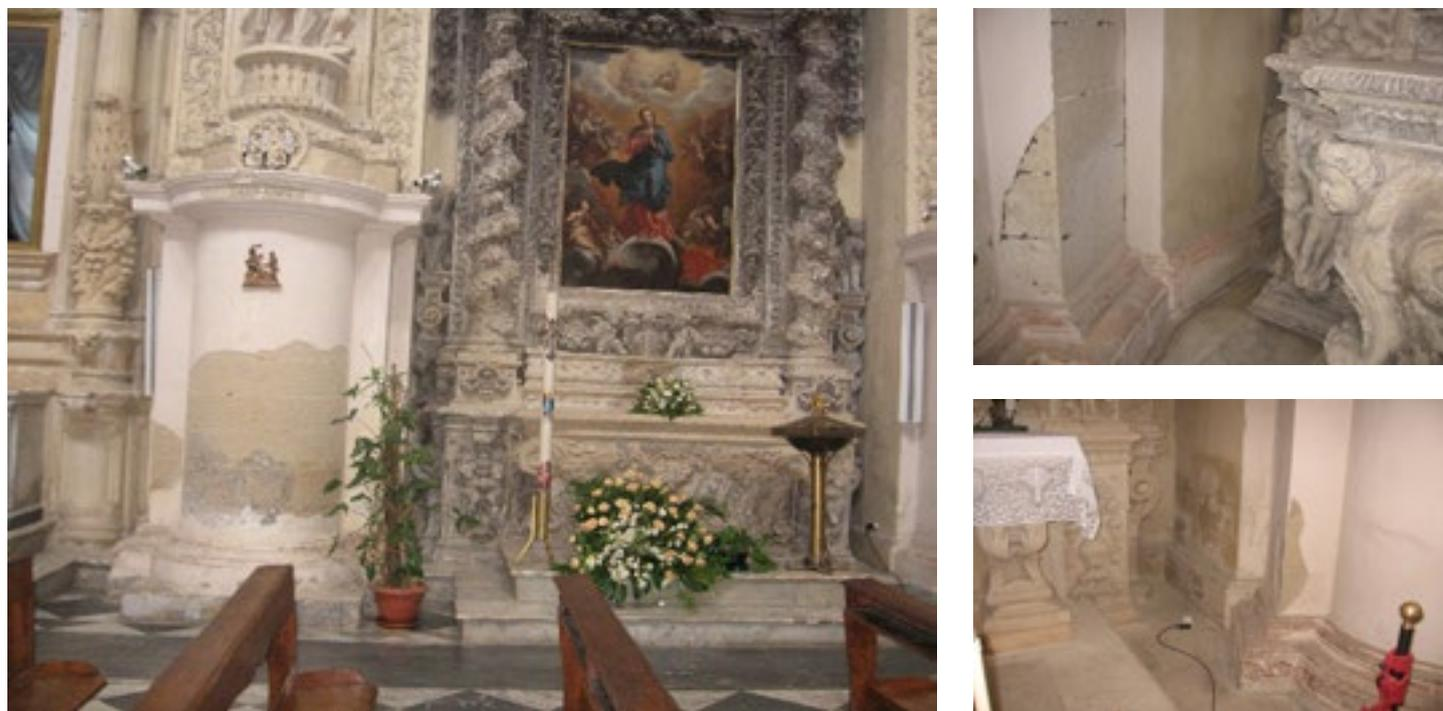
Fig.5 - Diffusi ammaloramenti delle superfici murarie causati dall'umidità capillare.
