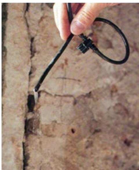
Fig. 9 - Desalinizzazione dei muri – particolare dei tubi utilizzati.
