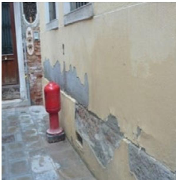
*Fig. 8 - Intonaci deumidificanti: la loro efficacia nel permettere la traspirazione del muro è limitata nel tempo.*
