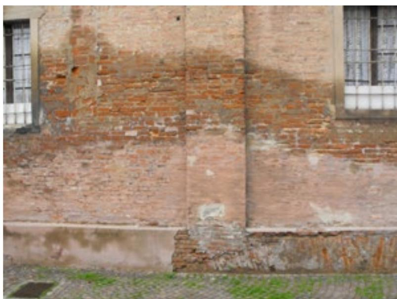
*Fig.2 - Esiti postumi (ricomparsa dell'umidità) su una muratura precedentemente trattata con barriera chimica.*
