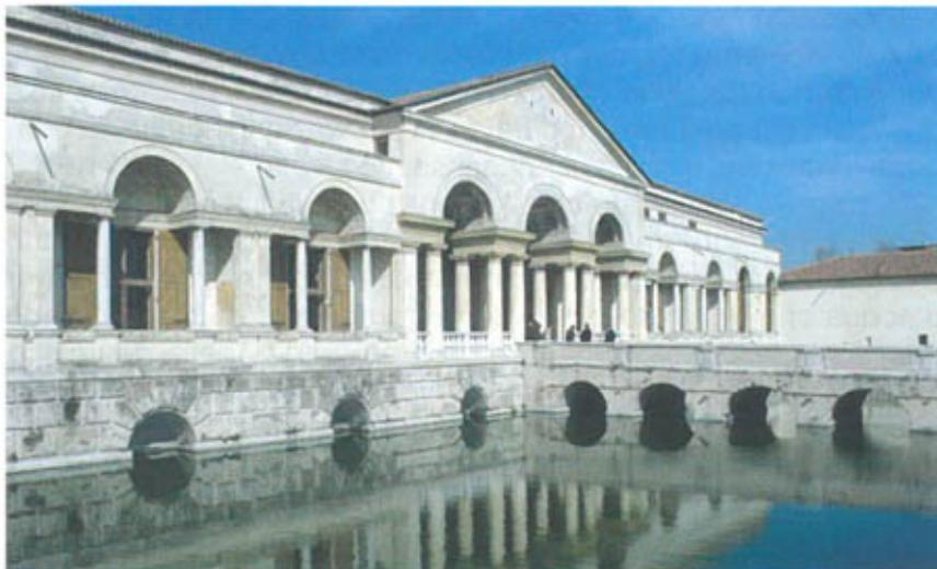
A fronte di una grave problematica quale quella dell'umidità ascendente che da epoca storica affliggeva l'edificio, nel corso di vari anni erano stati sperimentati a Palazzo Te diversi sistemi alternativi (impianto ad elettroosmosi in una zona, apparecchio elettrofisico di vecchia generazione in un'altra zona, ecc.) che non avevano dato risultati apprezzabili o, comunque, definitivi.
