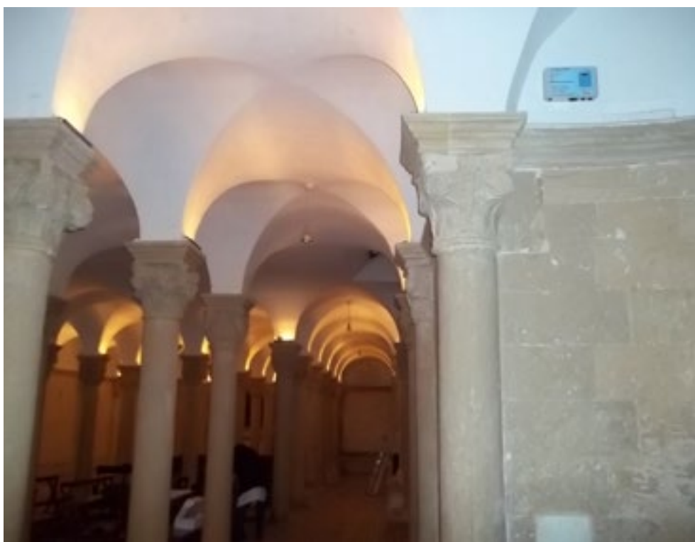
Fig. 6 - Installazione dispositivo DOMODRY all'interno della cripta del Duomo di Lecce.
