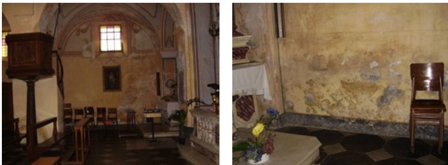
Fig. 2 - Il Santuario di Nostra Signora del Bosco: i problemi di umidità all'interno.
