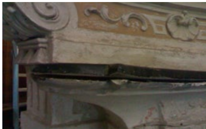
Fig. 20 - L'altare in stucco, completamente sfarinato e a rischio di crollo.
