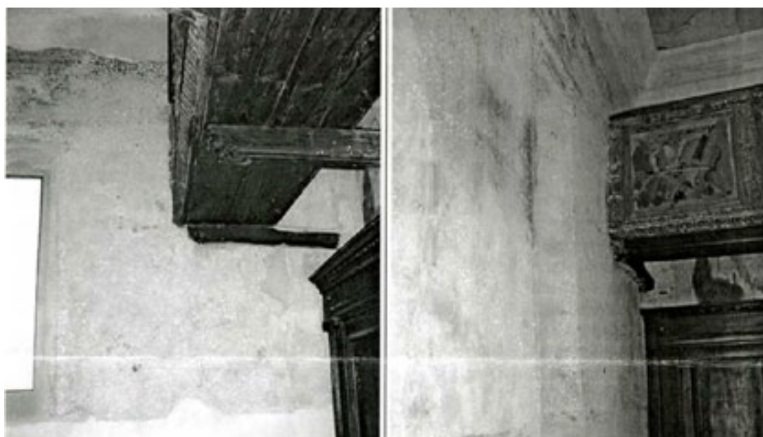
Fig. 34 - Scene ad affresco irrimediabilmente perdute a seguito del persistere dell'umidità interna all'edificio e forse per l'utilizzo nell'esecuzione del restauro di prodotti poi rivelatisi non del tutto idonei.
