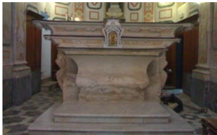
Fig. 20 - L'altare in stucco, completamente sfarinato e a rischio di crollo.
